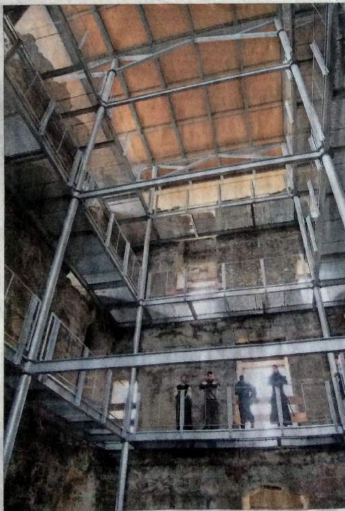
Le château d'Illens, qui était un pavillon de chasse au XV e siècle, vit une seconde jeunesse grâce à d'importants travaux de rénovation. Pour soutenir le toit plat, une structure en métal a été installée à l'intérieur du bâtiment. On peut ainsi mieux visualiser les trois étages d'origine. Quant à la cave, les voûtes en métal témoignent de l'architecture de l'époque. PHOTO: ANISHE VUKOBIC
