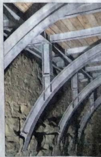
Le château d'Illens, qui était un pavillon de chasse au XV e siècle, vit une seconde jeunesse grâce à d'importants travaux de rénovation. Pour soutenir le toit plat, une structure en métal a été installée à l'intérieur du bâtiment. On peut ainsi mieux visualiser les trois étages d'origine. Quant à la cave, les voûtes en métal témoignent de l'architecture de l'époque. PHOTO: ANISHE VUKOBIC
